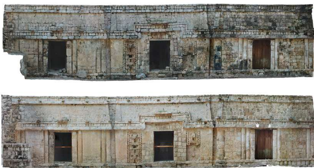
Fig. 3 Felix Camacho Zamora, fachada norte del Cuartel en el sitio arqueológico de Santa Rosa Xtampak, Campeche, 2018, Archivo Técnico Sección de Restauración INAH Campeche. En la imagen se muestra la fachada previa (superior) y posterior a la intervención de conservación–restauración por parte del Proyecto CESAC en el año 2018. Ambas imágenes son ortofotos exportadas de un modelo tridimensional realizado por la técnica de fotogrametría por medio de fotografía aérea.
